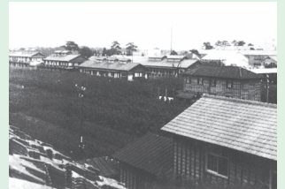
小金井の新校舎
