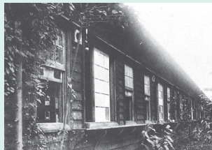
寄宿舎の外観
