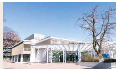
工学部総合会館
