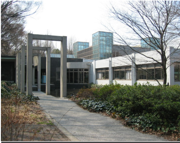
付属図書館小金井分館 (1,588 m 2 , 1970 年(昭和 45 年)建設、1996 年改修)
