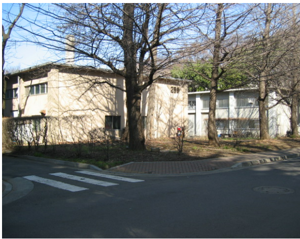
2号館 (右 300 m 2 , 1967(昭和37年)建設, 左 560 m 2 , 1976年(昭和51年)建設))
