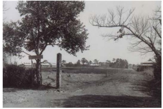
小金井校舎建設中 (昭和 11 年頃)
