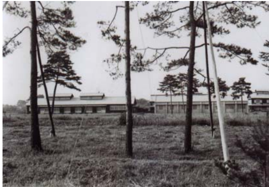
小金井校舎建設中、前方は蚕室 (昭和 11 年頃)
