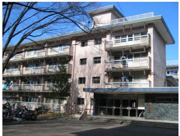
櫛寮 (5,759 m 2 , 1966 年(昭和 41 年)建設)
