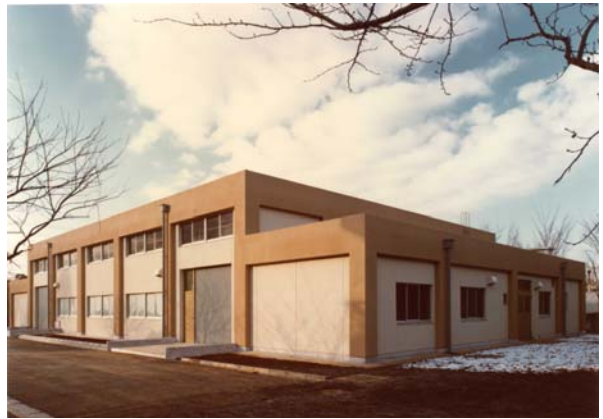
繊維博物館別館(旧繊維実習室) (1,171 m 2 , 1978 年(昭和 53 年)建設、 1997 年(平成 9 年)改修)
