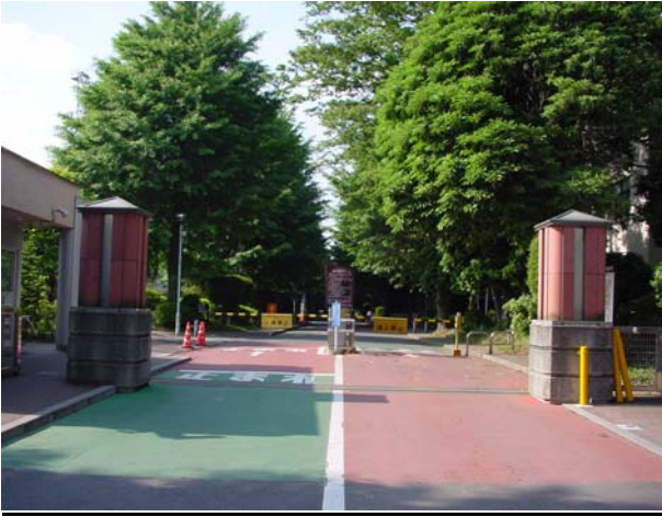
正門 (1998年(平成10年)改修)
