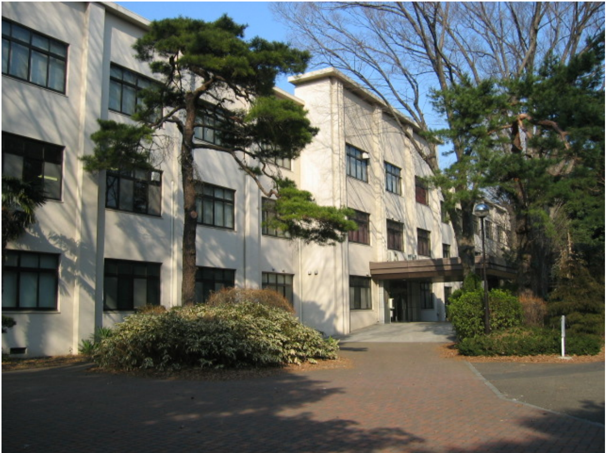
工学部附属繊維博物館(1937 年(昭和 12 年)建設、3,008 m 2 )
