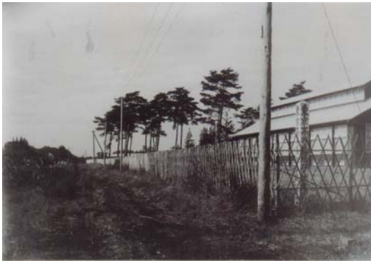
小金井校舎建設中 (昭和 11 年頃)
