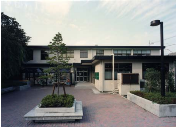
総合会館(生協) (1,678 m 2 , 1966 年(昭和 41 年)建設)
