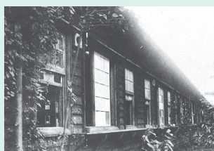
寄宿舎の外観
