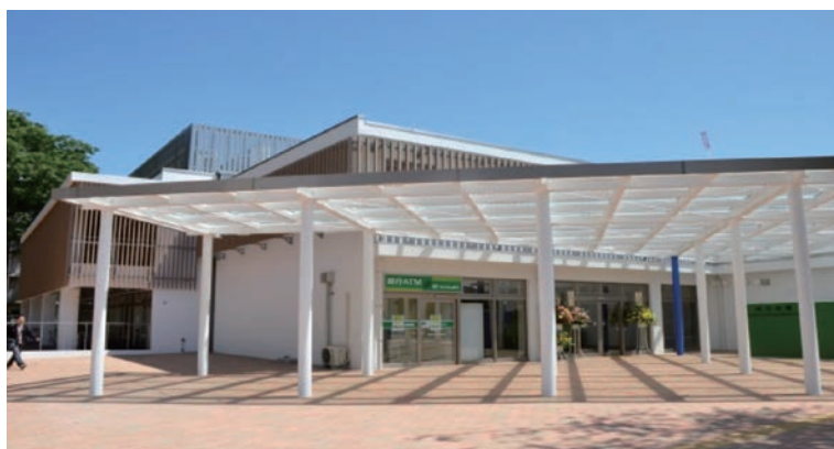
工学部総合会館
