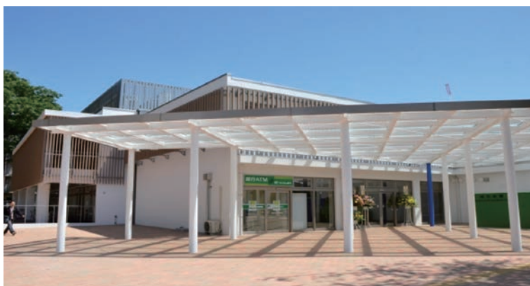
工学部総合会館
