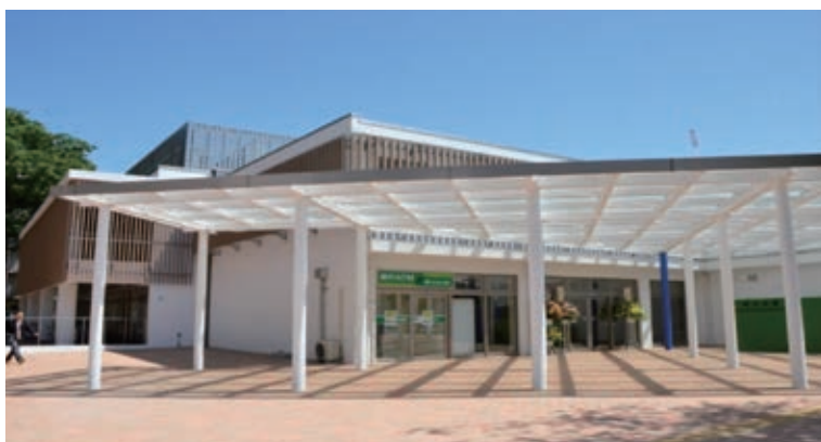
工学部総合会館
