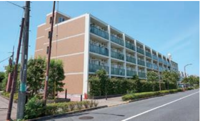
檜寮外観（北側）
