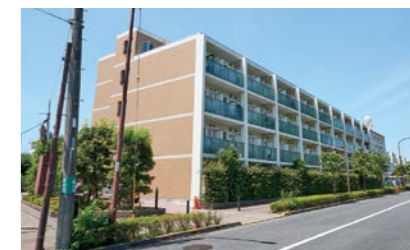
檜寮外観(北側)
