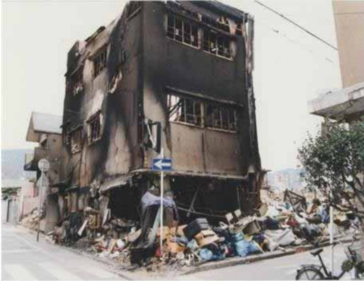
灘区の被災した民家
