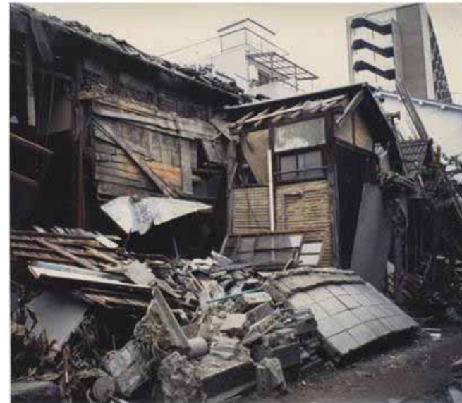
灘区の崩壊した民家
